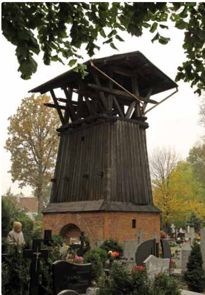
Zabytkowa, murowano-drewniana dzwonnica na cmentarzu w Starym Polu
