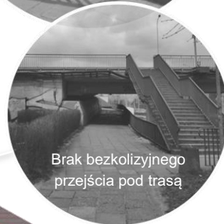
Schody, brak windy
